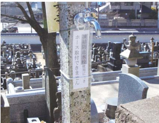
▲凍結防止栓を水道に設置
