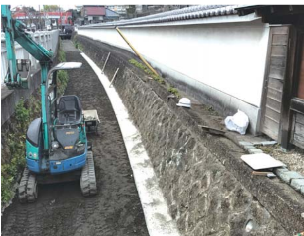
擁壁の下を鉄筋コンクリートで支えました
